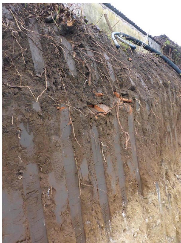
Budapest, III. Aranyvölgy út 19/a. A lejtős hegyoldal legmélyebbi pontján, mintegy 3 m mélységű munkagödör É-i és Ny-i falában természetes rétegsor látszik.
