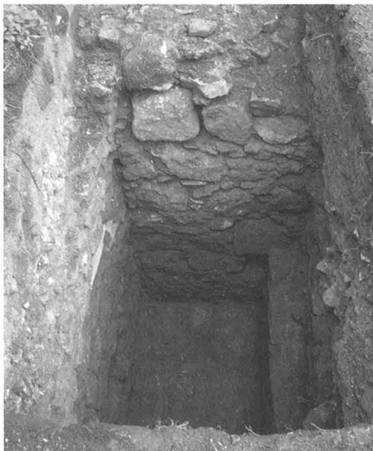
Tokaj, Rákóczi-vár. A K-i ágyútoronyba vezető, a belső vár árkán átívelő kőhíd D-i falának Ny-i indítása
