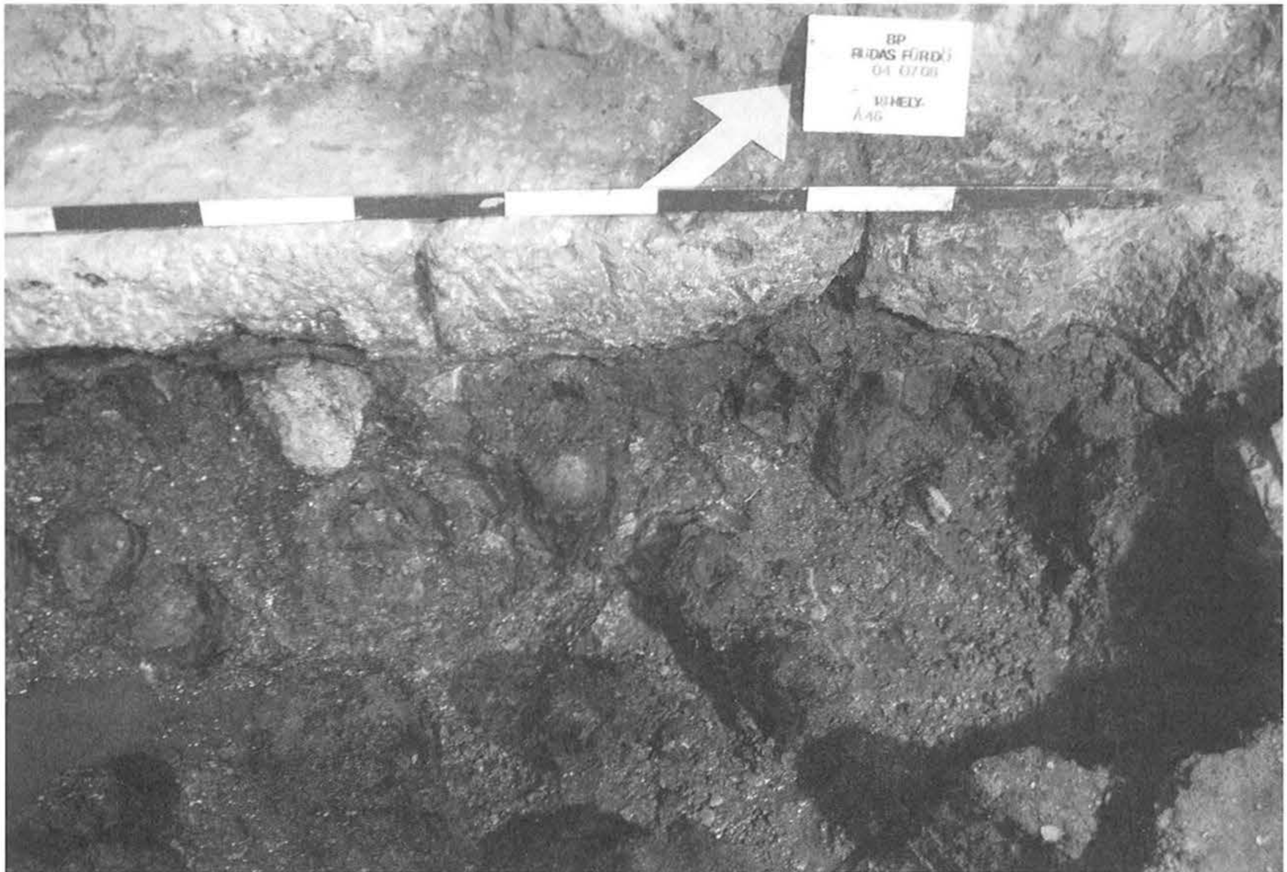
23. kép: Bp., Rudas fürdő. A 18. helyiségben a nagymedence legalsó török kőlépcsője és a török facölöpök Fig. 23: Bp., Rudas bath. The last Turkish step of the of the large basin and Turkish wooden posts in room no. 18
