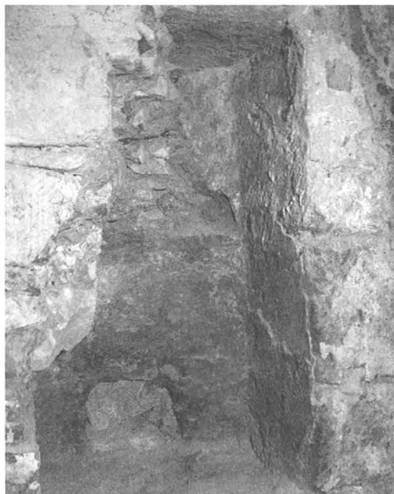
6. kép: Bp., Rudas fürdő. A 26. helyiség északi falában talált török fülke kibontás után
