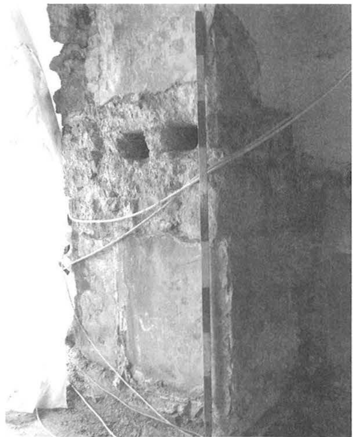
25. kép: Bp., Rudas fürdő. A 25. helyiség északi (török) falában látható koszorúgerenda-fészkek Fig. 25: Bp., Rudas bath. Crossbeam pockets in the northern (Turkish) wall of room no. 25.
