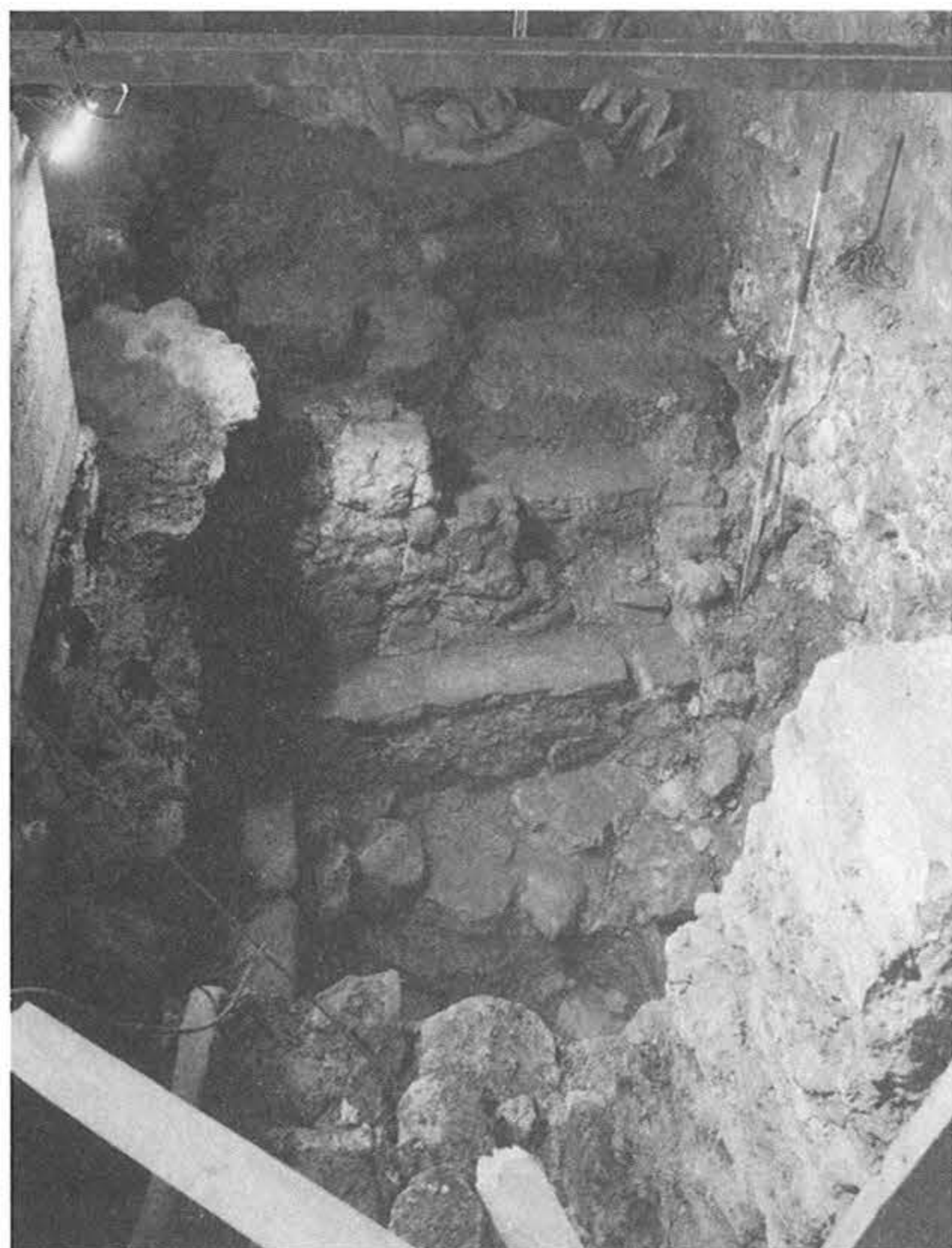
26. kép: Bp., Rudas fürdő. A kupolatér keleti fala mentén felszínre került, kőből falazott lépcsős vízvételi hely
