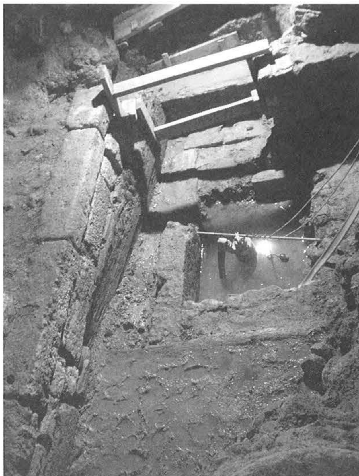
27. kép: Bp., Rudas fürdő. A kupolatér délnyugati kismenedéje alatt felszínre került középkori forrásfoglalás
