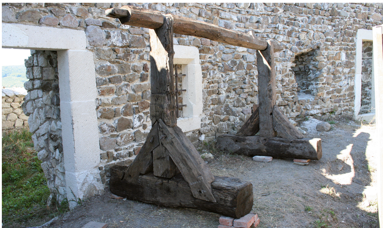
Füzér, vár. A kút konzerválódott felvonószerkezete.
