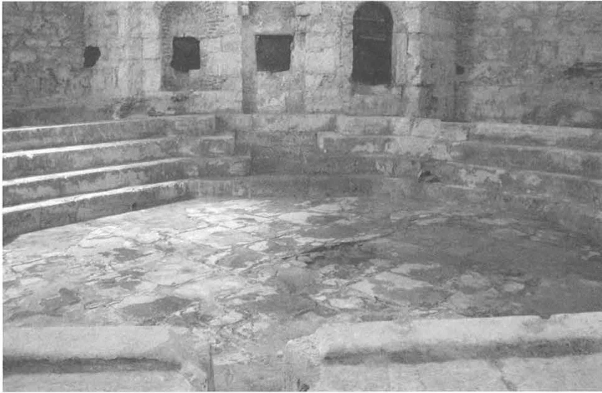
8. kép: A sicaklık épen felszínre került török kőpadlója Fig. 8: The intact Turkish stone pavement of the sicaklık
