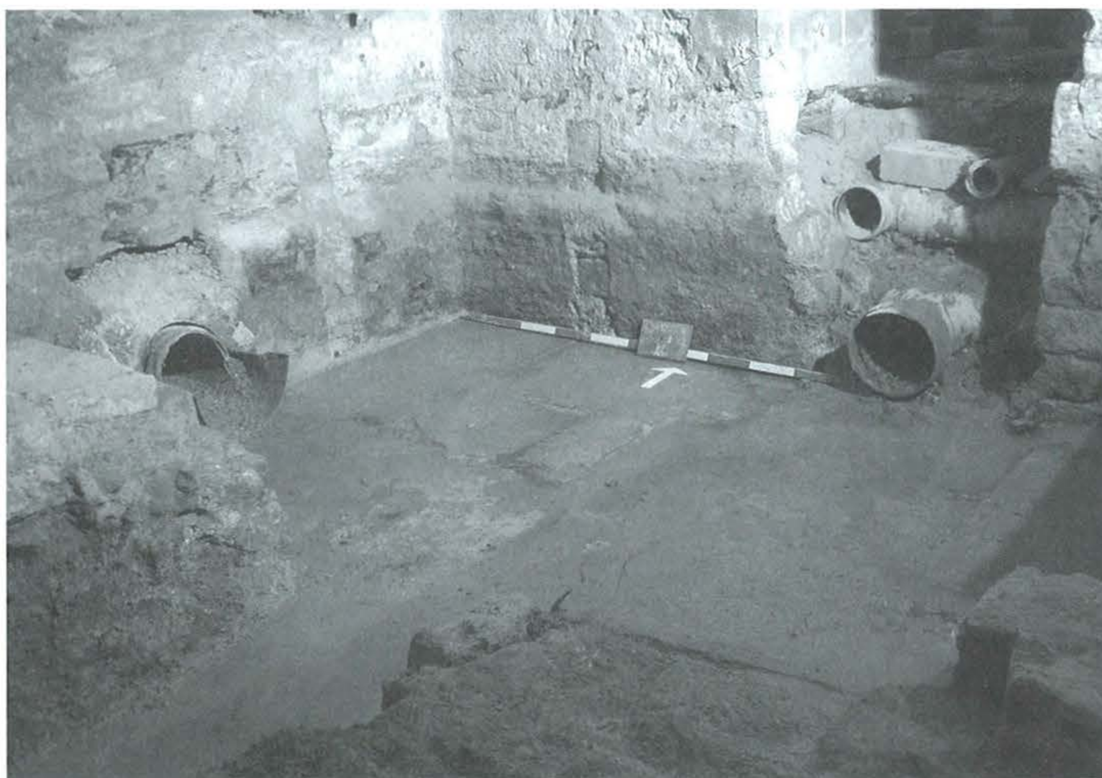
16. kép: Császár fürdő. Újkori kismedence a délnyugati sarokkupolában, 20.századi légtechnikai vezetékék által végzett pusztítás
