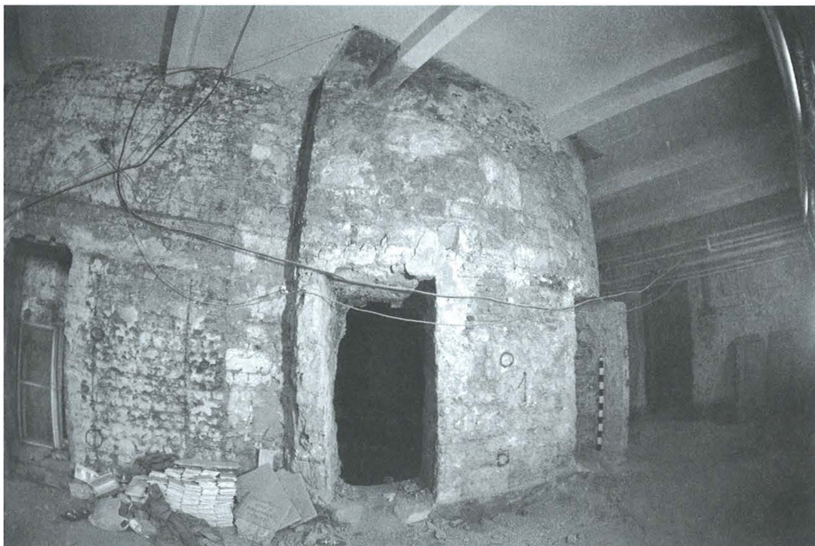
3. kép: Lukács fürdő. A toronytest és a csatlakozó 19-20. századi falazat észak felől Fig. 3: Lukács bath. Body of the tower and the attached 19 th -20 th century wall from the north
